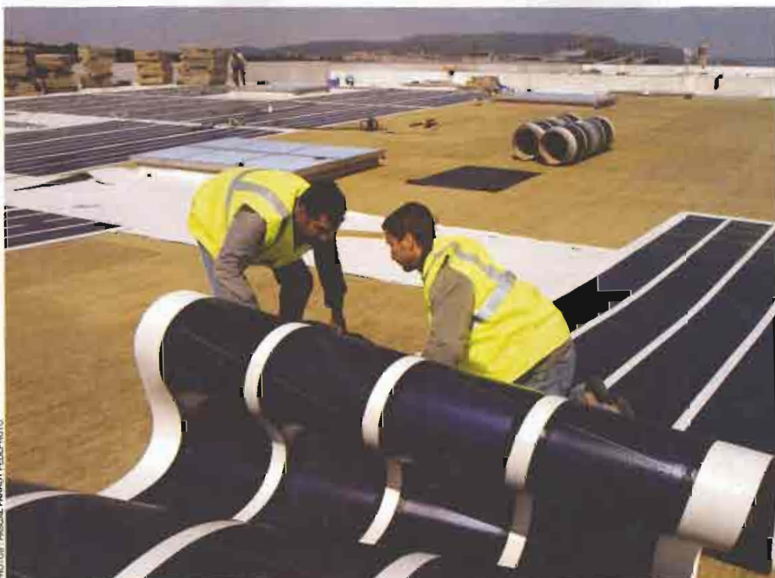
La toiture du bâtiment est en partie couverte de capteurs photovoltaïques intégrés dans une membrane souple. Son étanchéité est garantie vingt ans, autant que la performance électrique des modules.
