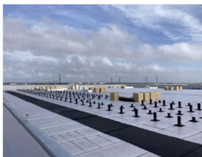
Figure 2 : Cheminement en SOPRATEC
