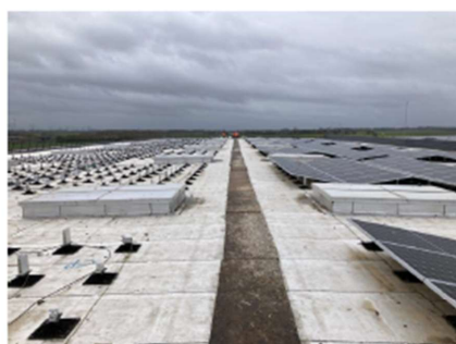
Figure 1 : cheminement en OSB
