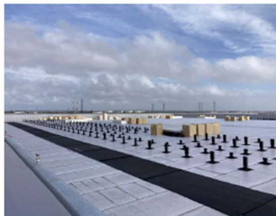
Figure 2 : Cheminement en SOPRATEC
